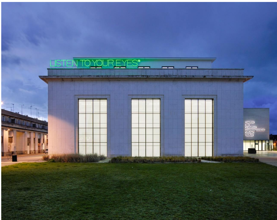
Fig. 5 Bâtiment du Centre de création contemporaine Olivier Debré, CCC OD, Tours. Projet d'architecture de l'atelier Aires Mateus, Portugal. Placé en surplomb de la façade, l'œuvre de Maurizio Nannucci, Listen to your eyes , 2010 (Collection du Centre national des arts plastiques). © F. Fernandez, CCC OD, Tours.
